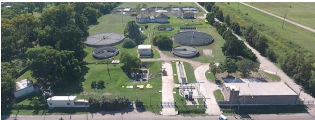
Planta Depuradora de Líquidos Cloacales
